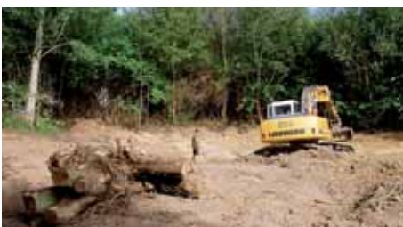
Der zugewachsene und verlandete Teich wird vom Aufwuchs befreit und tiefer gebaggert.
